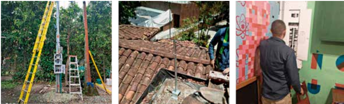
Imágenes del sistema de apantallamiento, cambio de contador y circuitos eléctricos en el Café.
